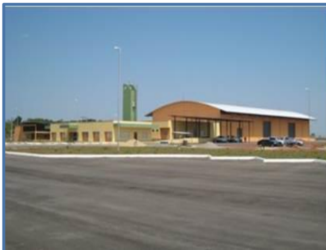
Instalações Administrativas e Galpão
