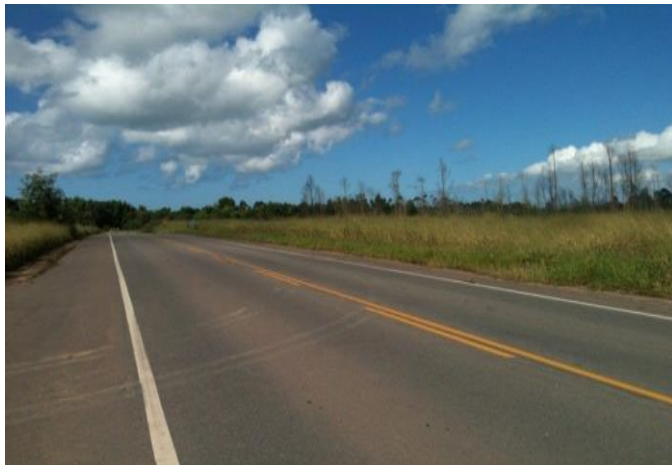
Via de acesso da ZPE de Aracruz/ES (Rodovia ES-010 – Km 070).
